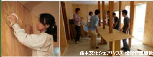
鈴木文化シェアハウス 改修作業風景
